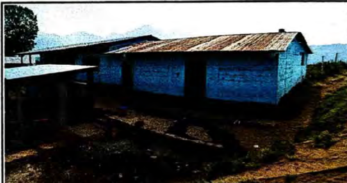
Foto 4: Sustrucción de estructura de techo del área de dirección.
