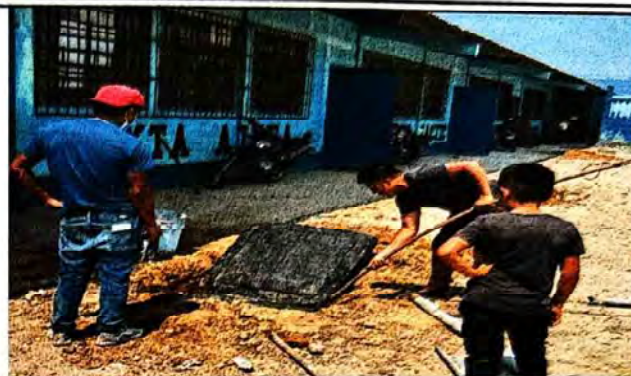
Foto 8: Reestructuración de red de drenaje y cambio de tubería de aguas negras.
