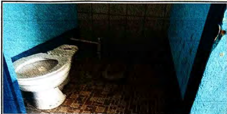
Foto 7: Cambio de Sanitario y reestructuración de red de drenajes
