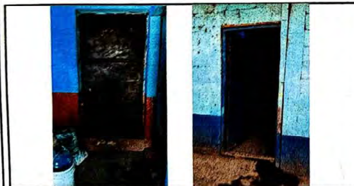
Foto 5: Sustrucción de puertas de cocina y bodegas.
